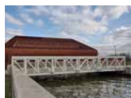
Pompstation Groot Schijn
